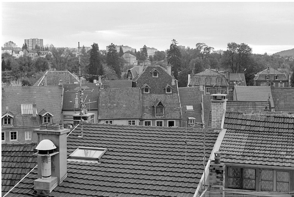
Vue d'ensemble de la toiture.
