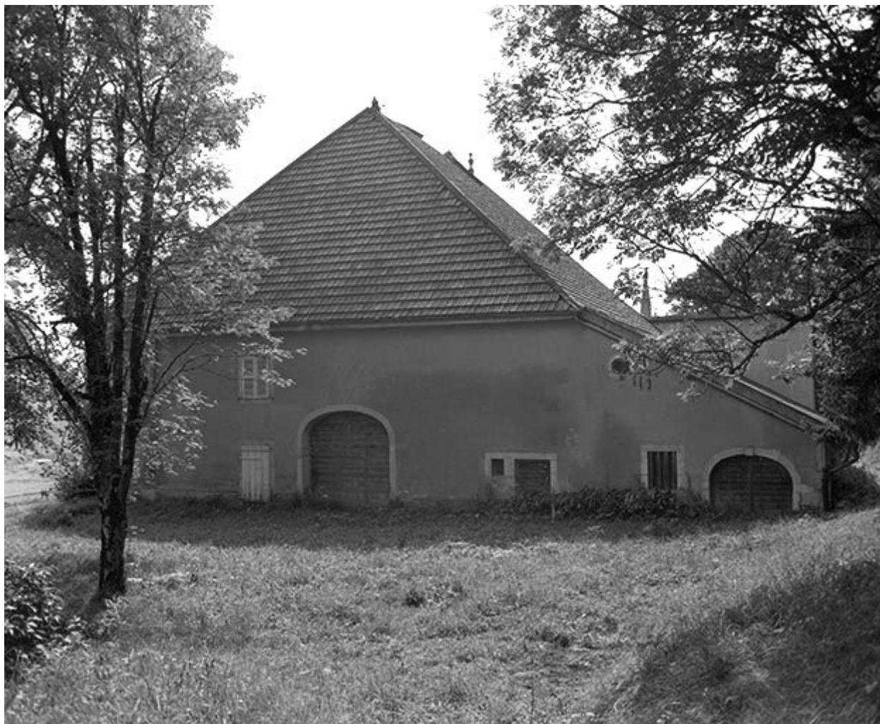
Façade latérale, vue depuis le parc.
