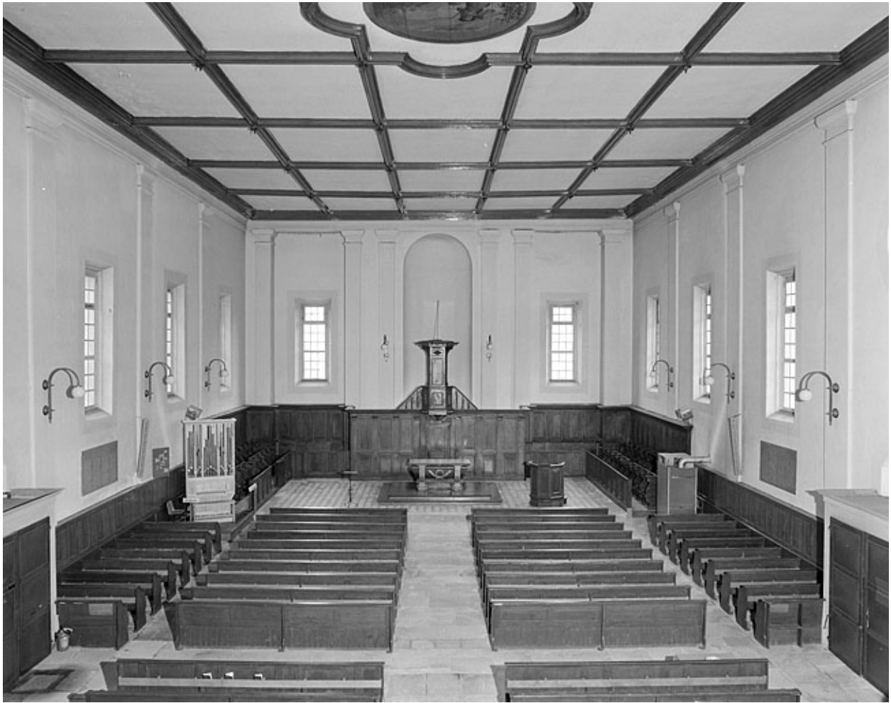
Vue intérieure vers l'est.
