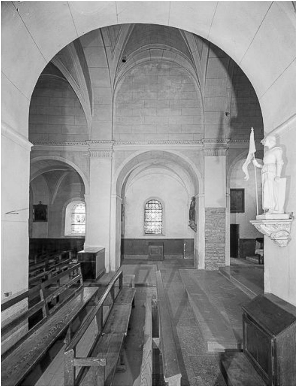
Intérieur : vaisseau central, 4e travée, élévation gauche.
