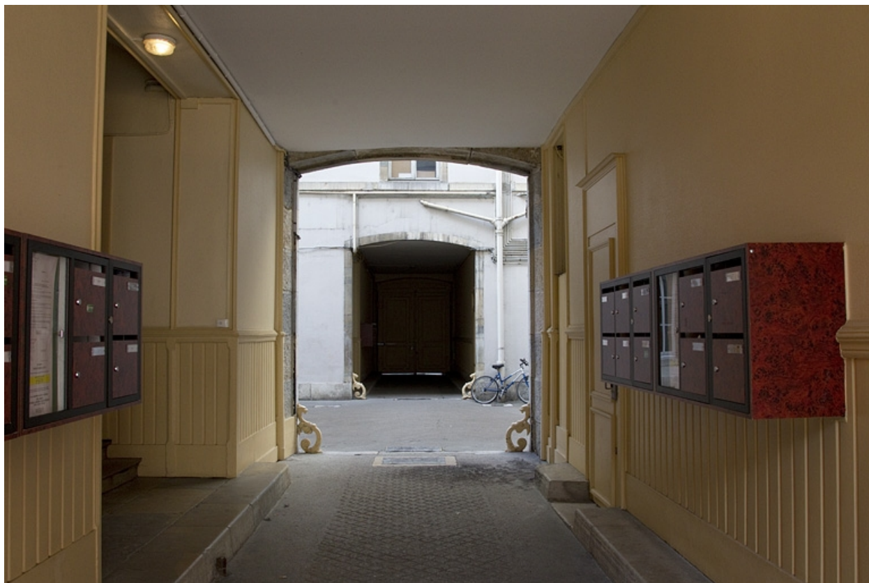
Vue d'ensemble des passages cochers en enfilade.
