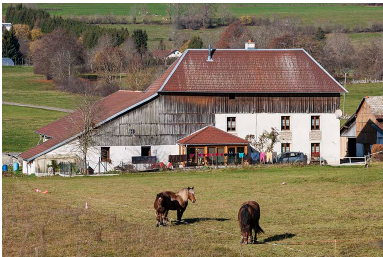
Ferme : façade sud.
