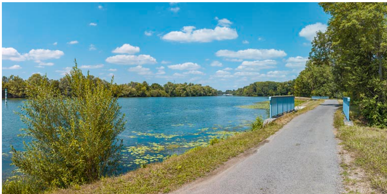
Vue d'ensemble des deux ponceaux, rive gauche.
