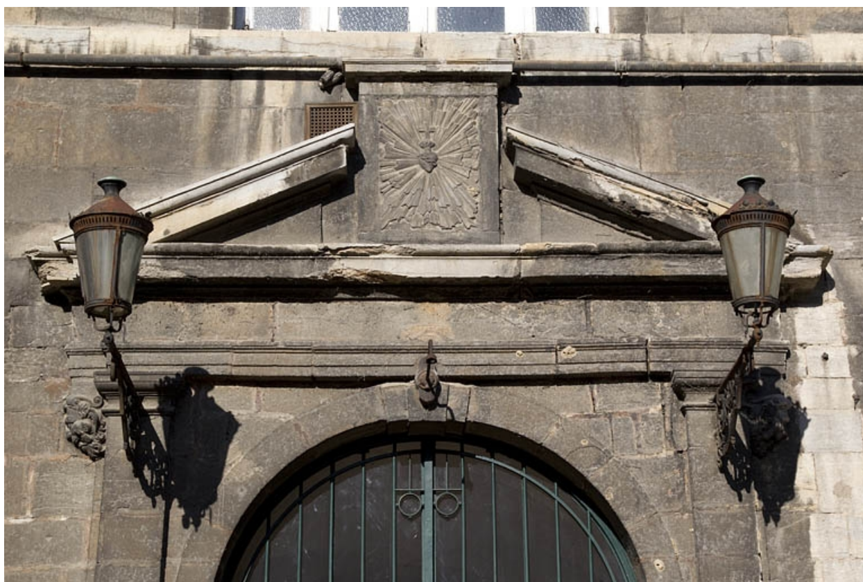
Façade antérieure, portail d'entrée : détail du fronton.
