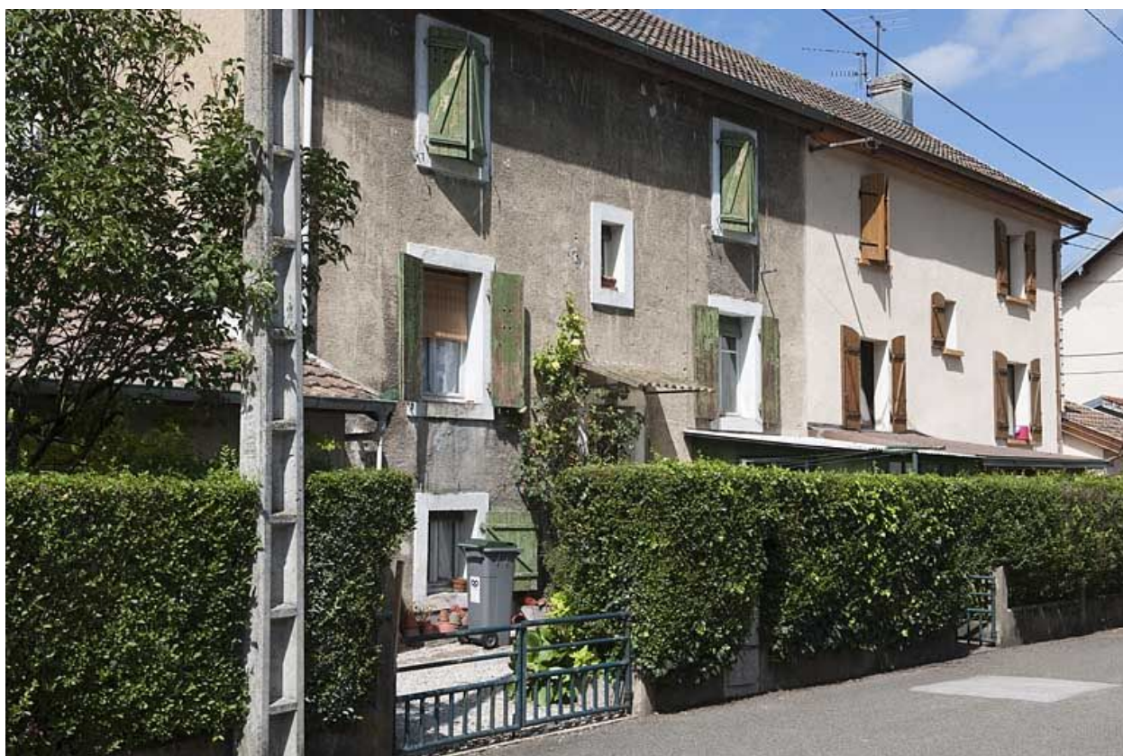
Détail d'une façade d'un habitation.
