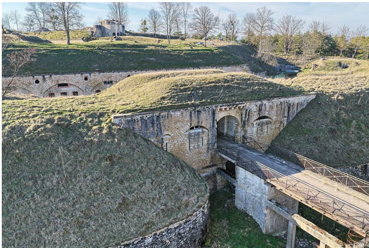
Le bâtiment d'entrée vu depuis l'exterieur du fort. (vue aérienne).
