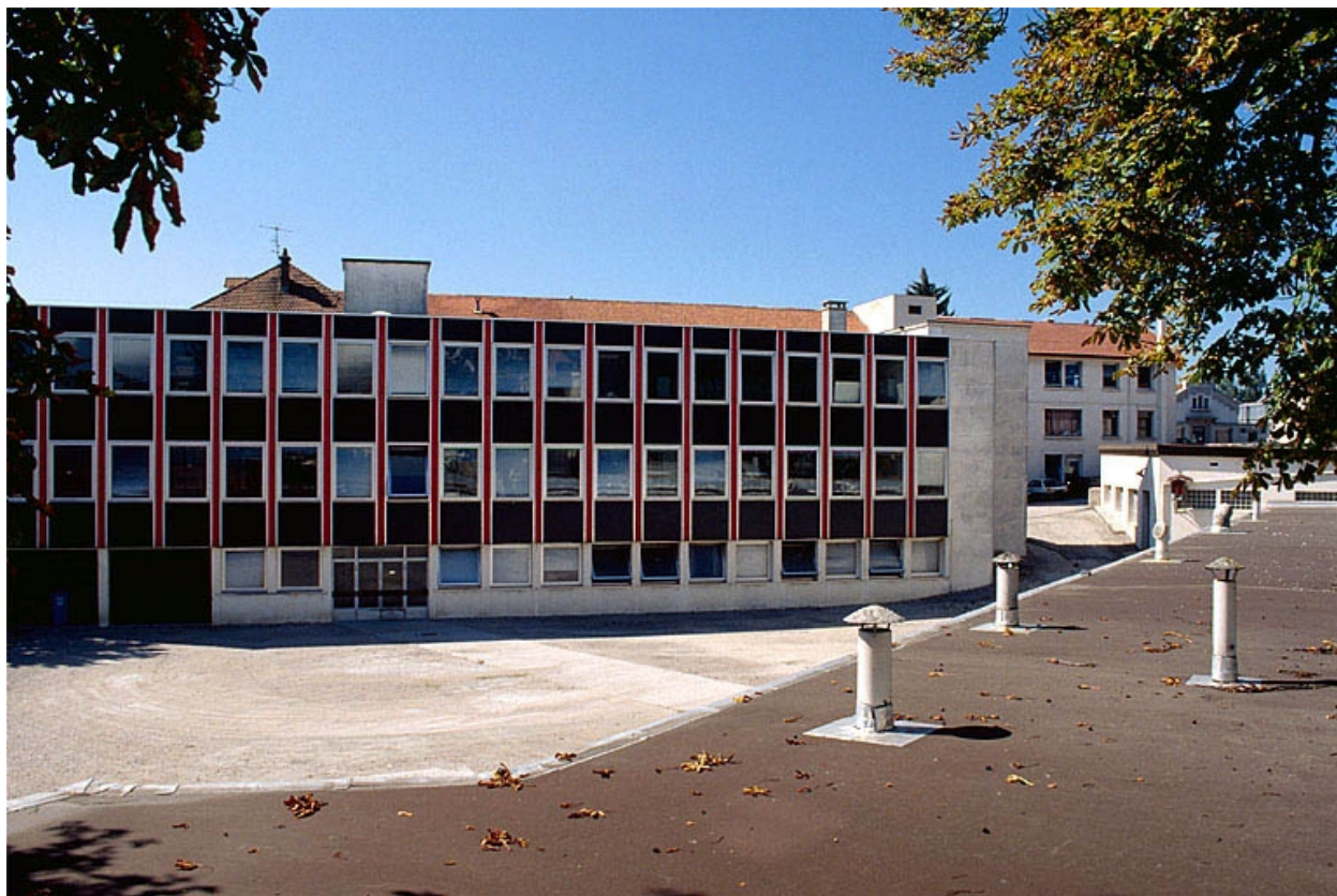
Usine de quincaillerie puis de lunetterie Girard, Champagnole (3 rue Baronne Delort).
