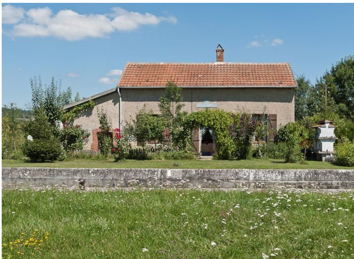
Vue de face de la maison éclusière.
