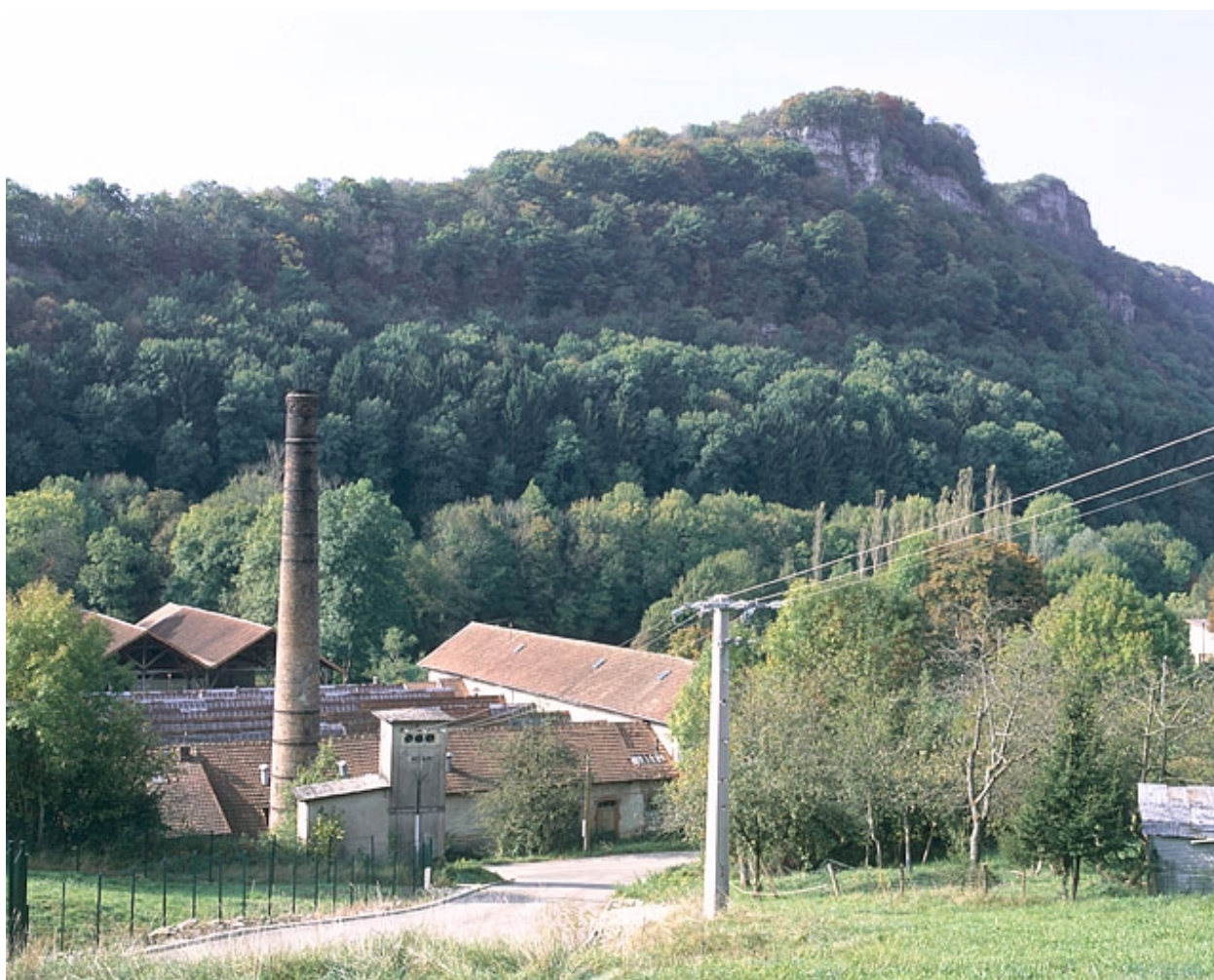
Vue des toitures depuis le nord.
