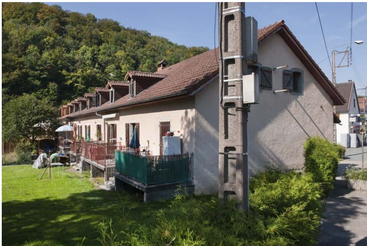
Caserne G. Façade postérieure vue depuis l'est.
