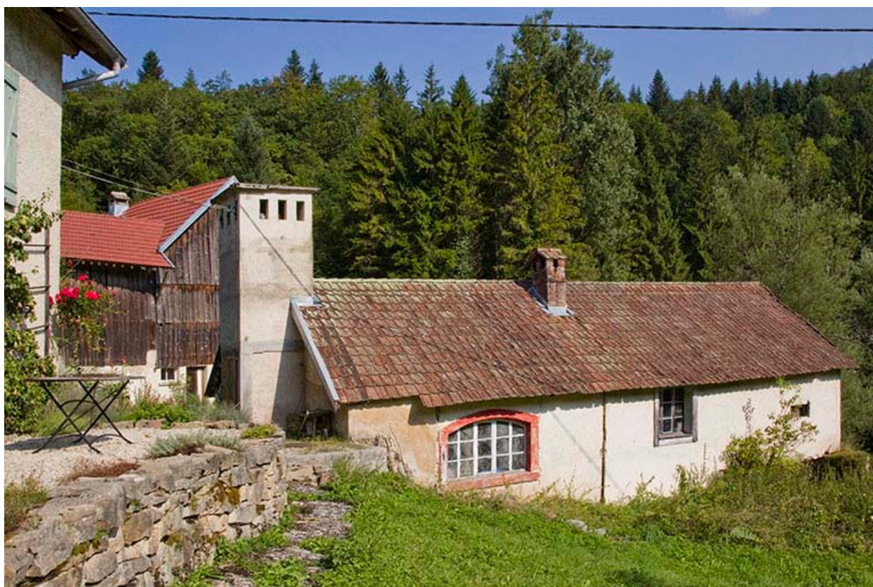
Centrale : façade postérieure, de trois quarts gauche.
