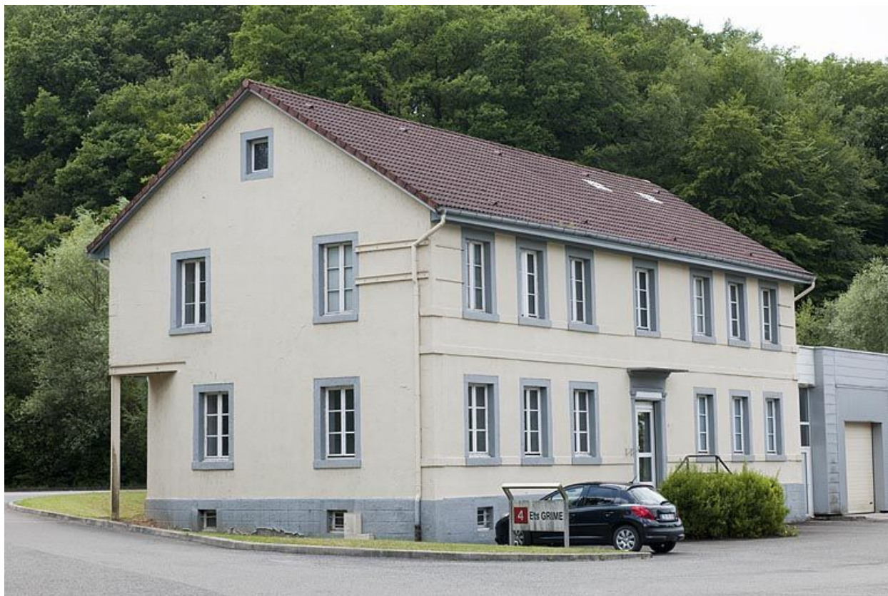
Ancien bâtiment des bureaux. Façade nord.
