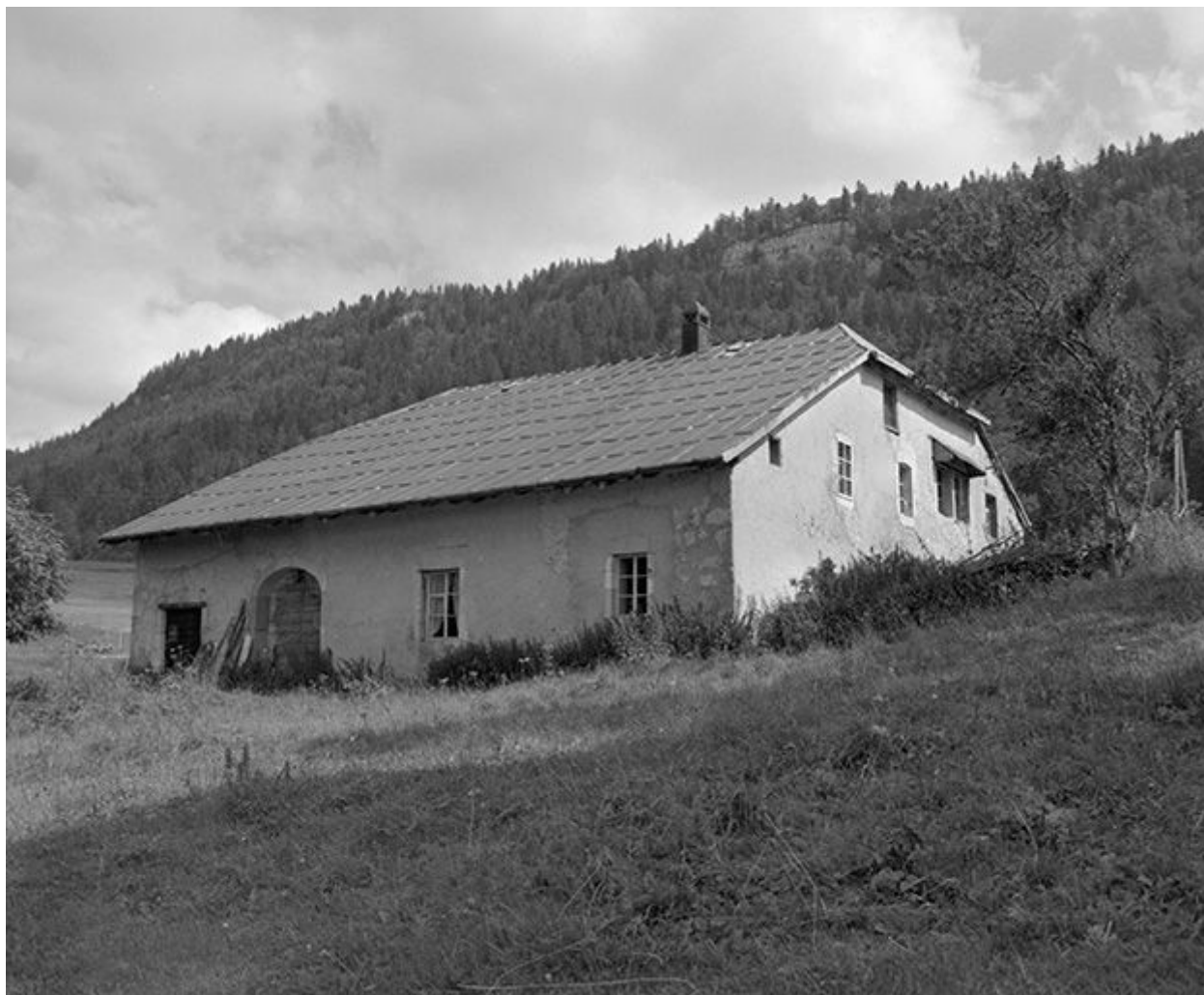
Façades postérieure et latérale gauche.
