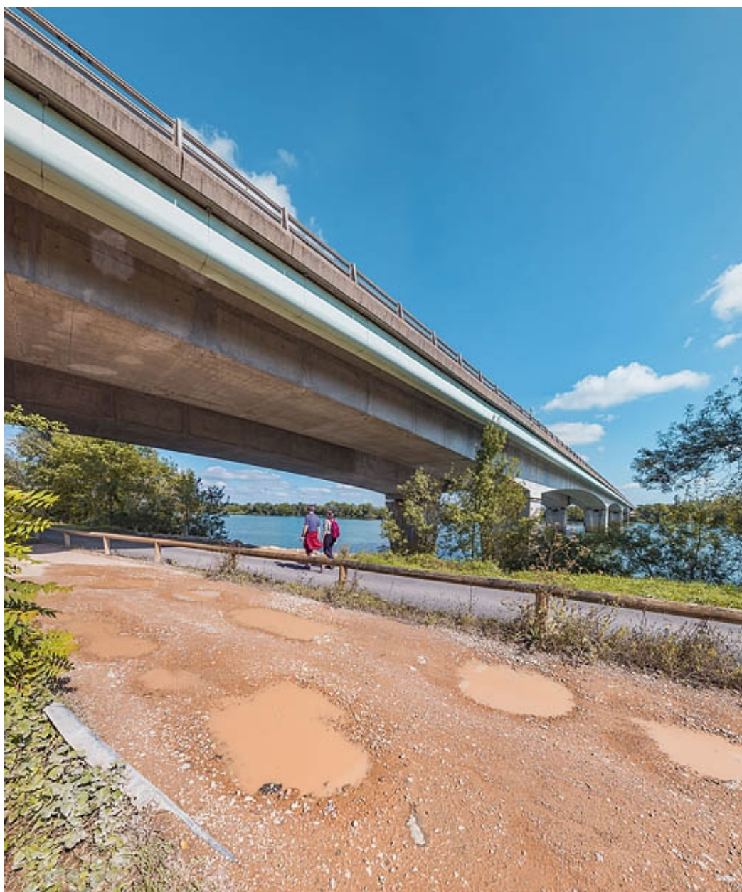
Le pont depuis la véloroute, rive droite.
