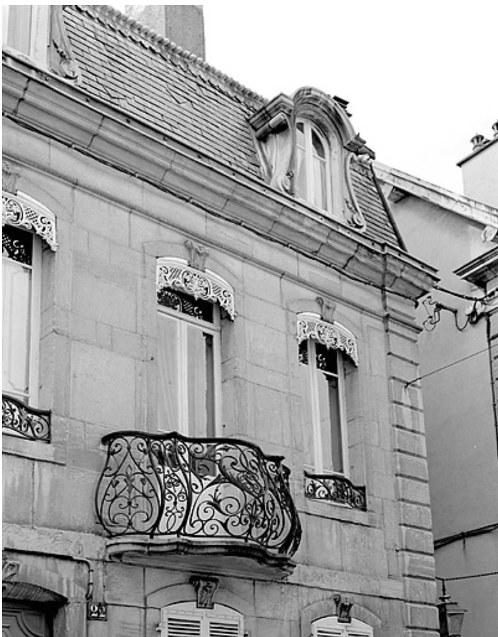
Façade antérieure, balcon.
