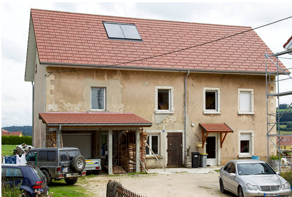
Bâtiment au n° 39 : façade antérieure.
