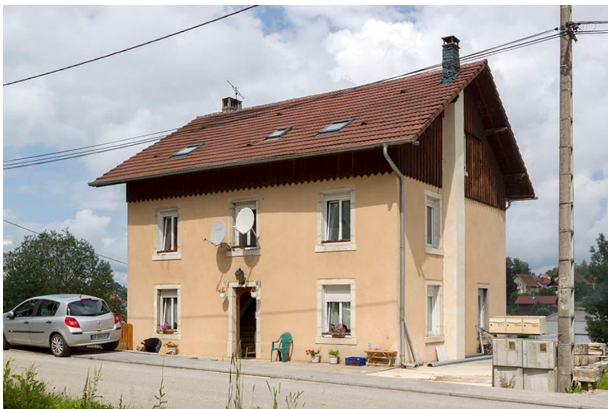
Façades antérieure et latérale droite.
