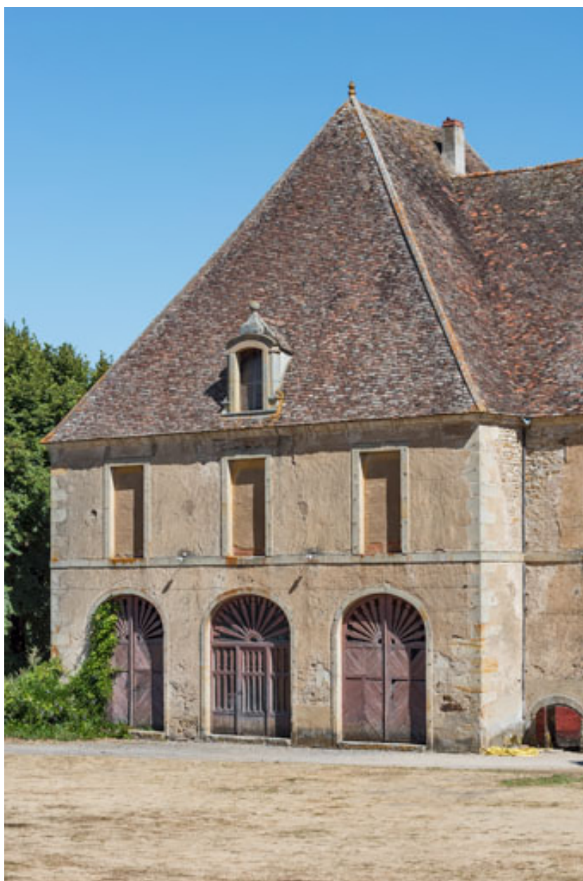
Façade antérieure : pavillon occidental (théâtre).
