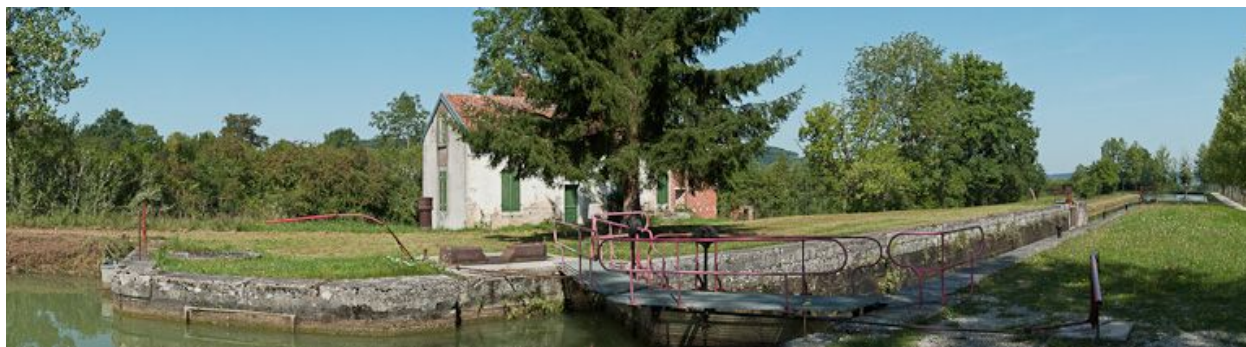
Vue d'ensemble du site d'écluse.
