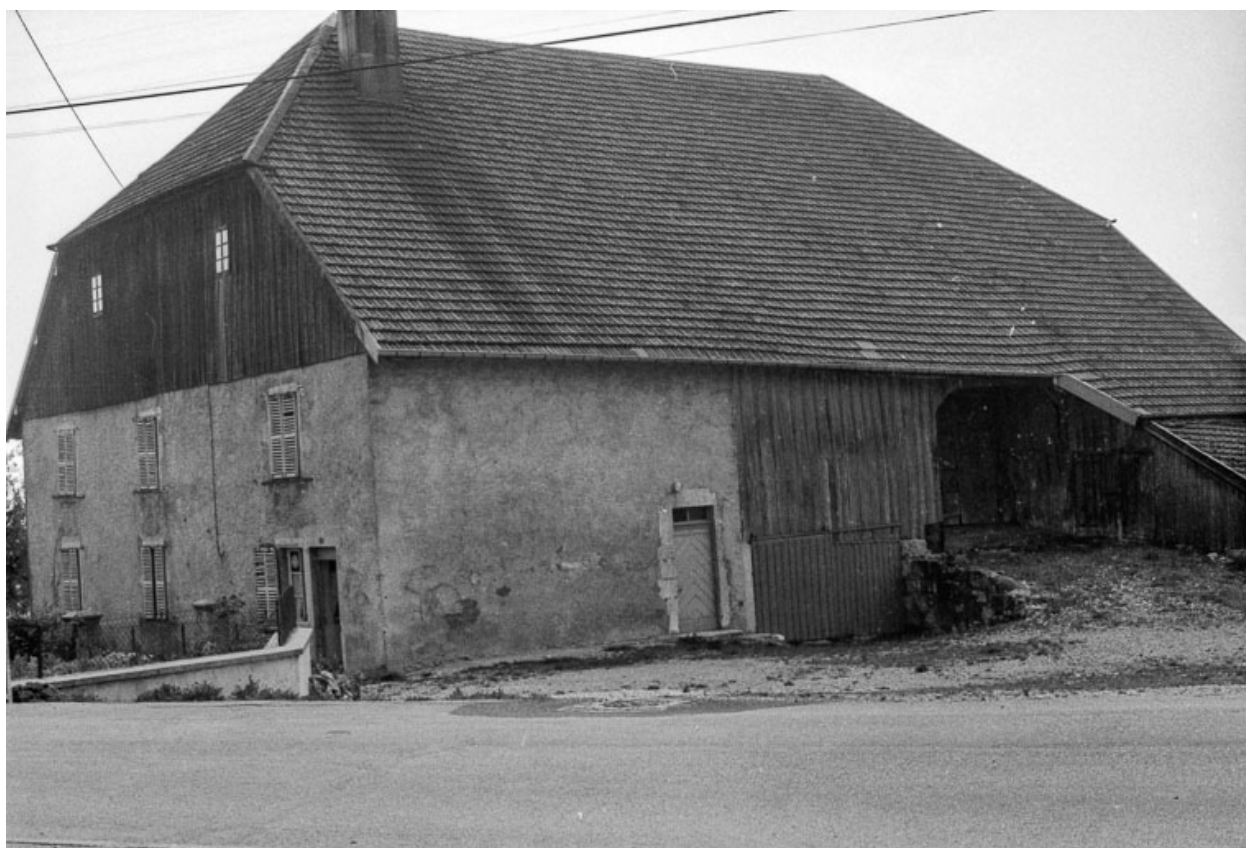
Ferme : façades antérieure et latérale droite.
