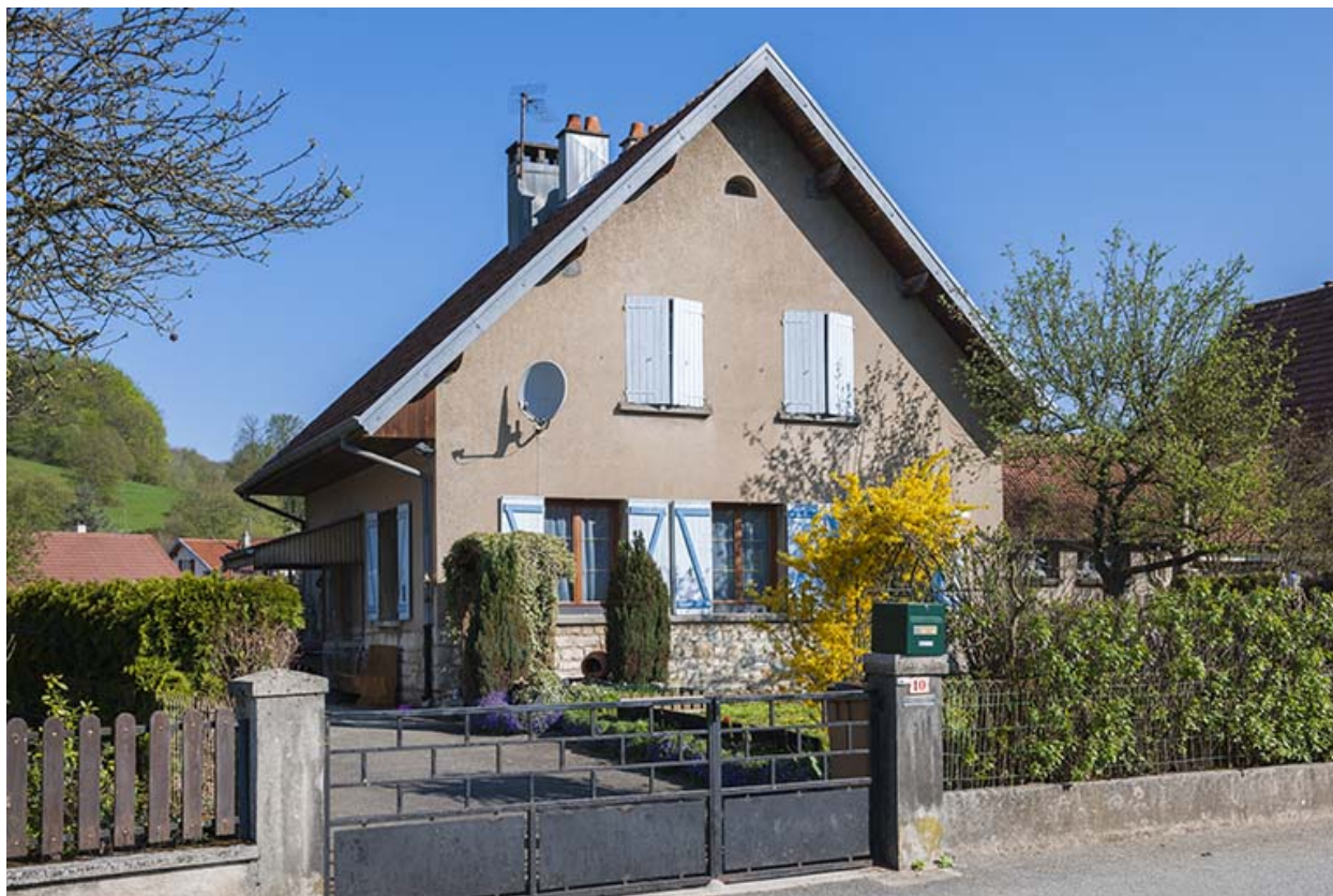
Façade antérieure d'une maison (rue des Ecoles).
