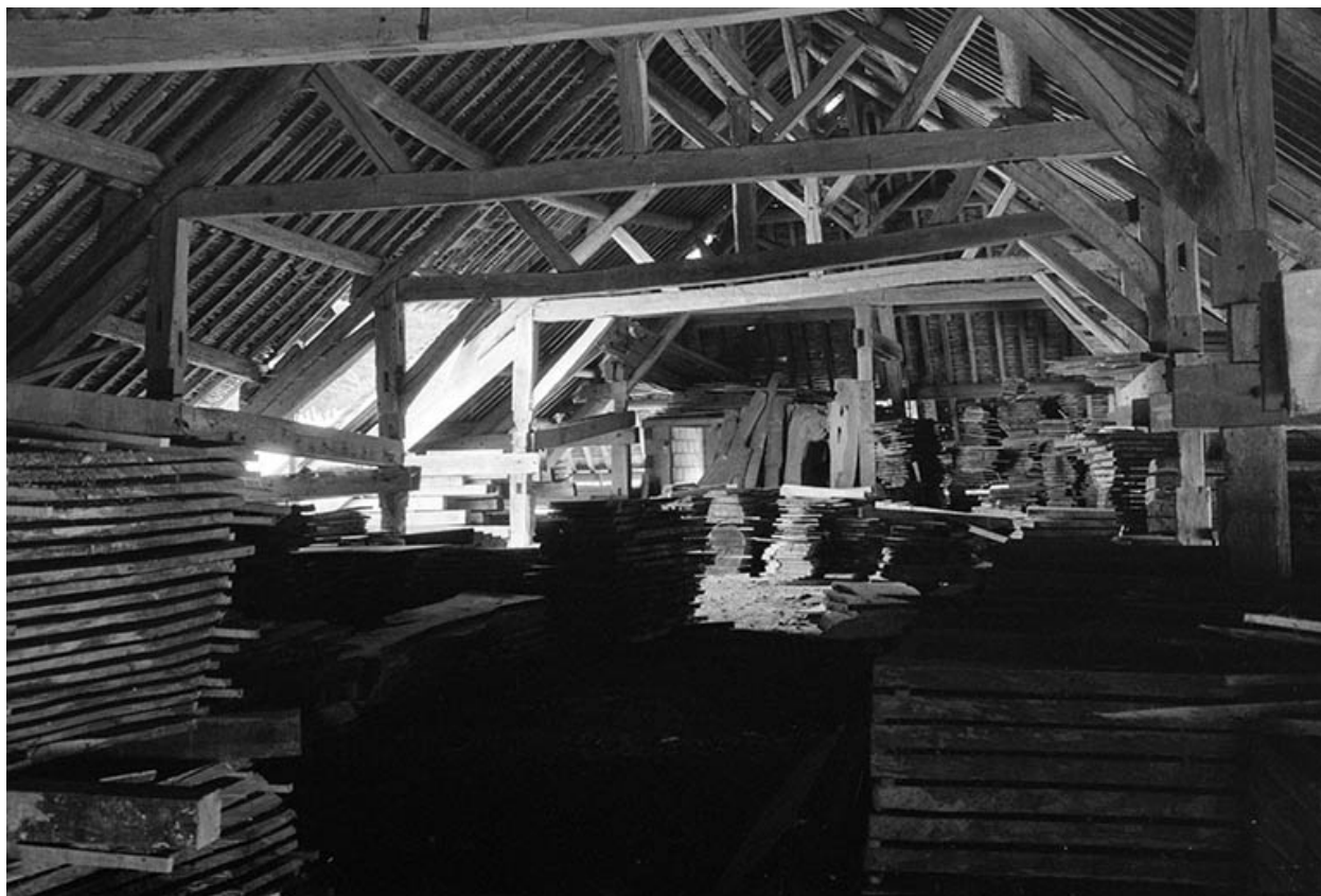
Intérieur de la halle de séchage.
