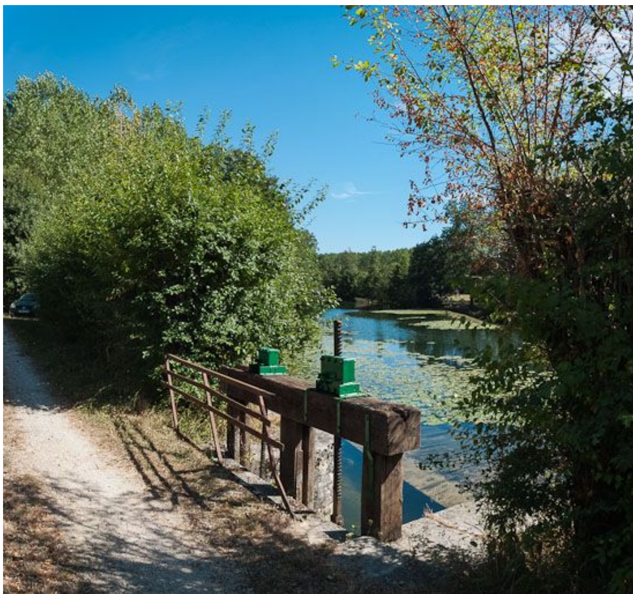
Détail des vannes.
