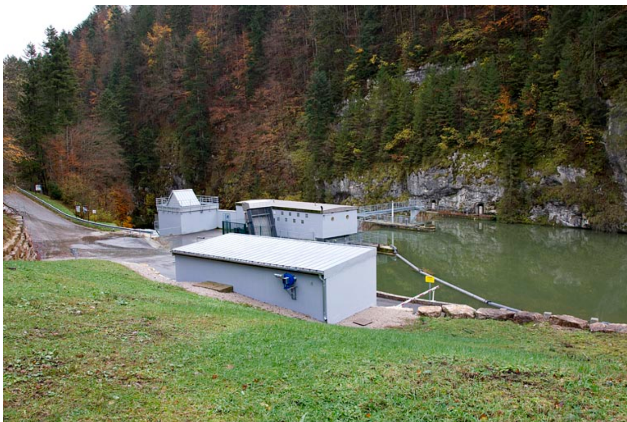
Vue d'ensemble depuis le nord-ouest (amont).
