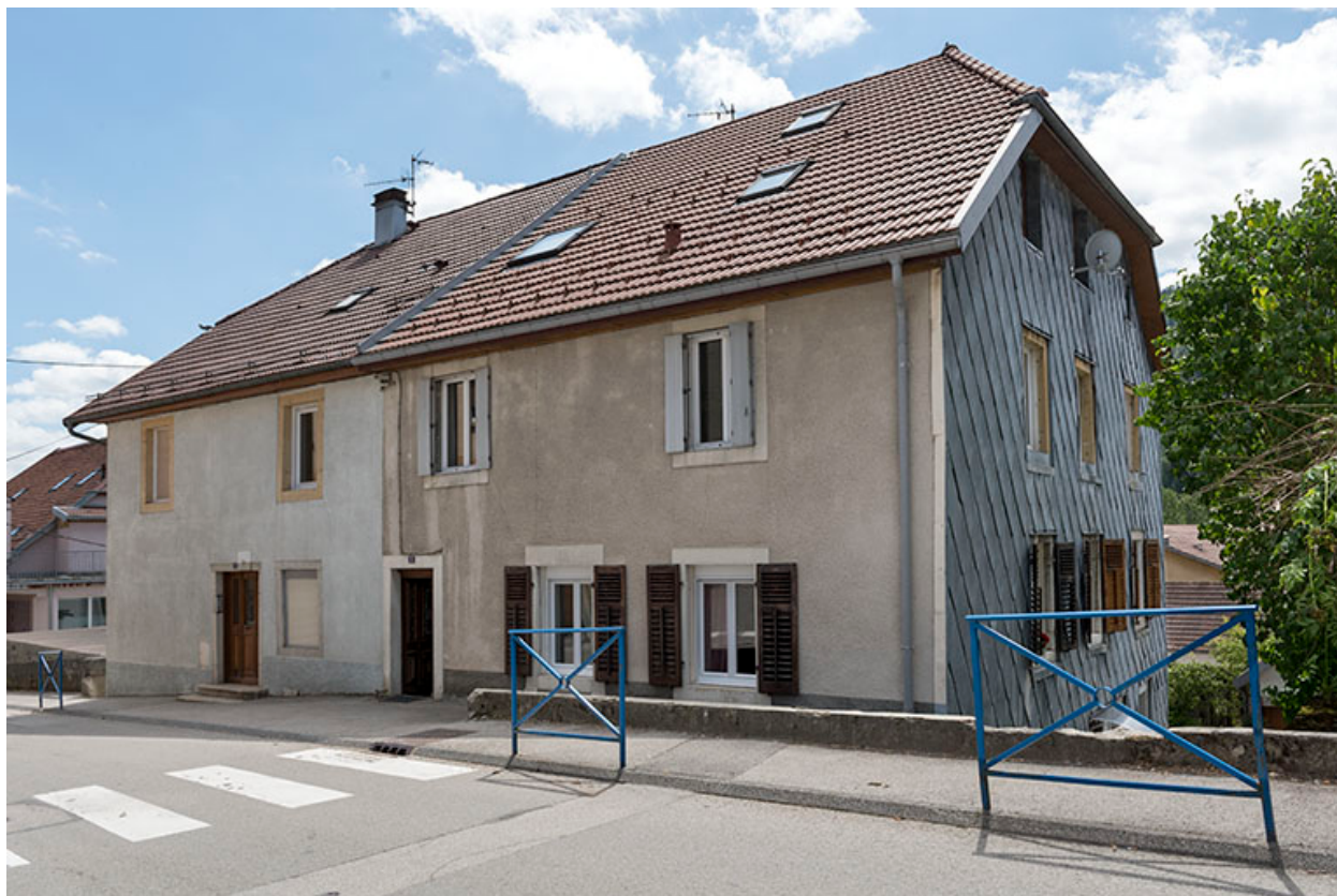
Façades antérieure et latérale droite.
