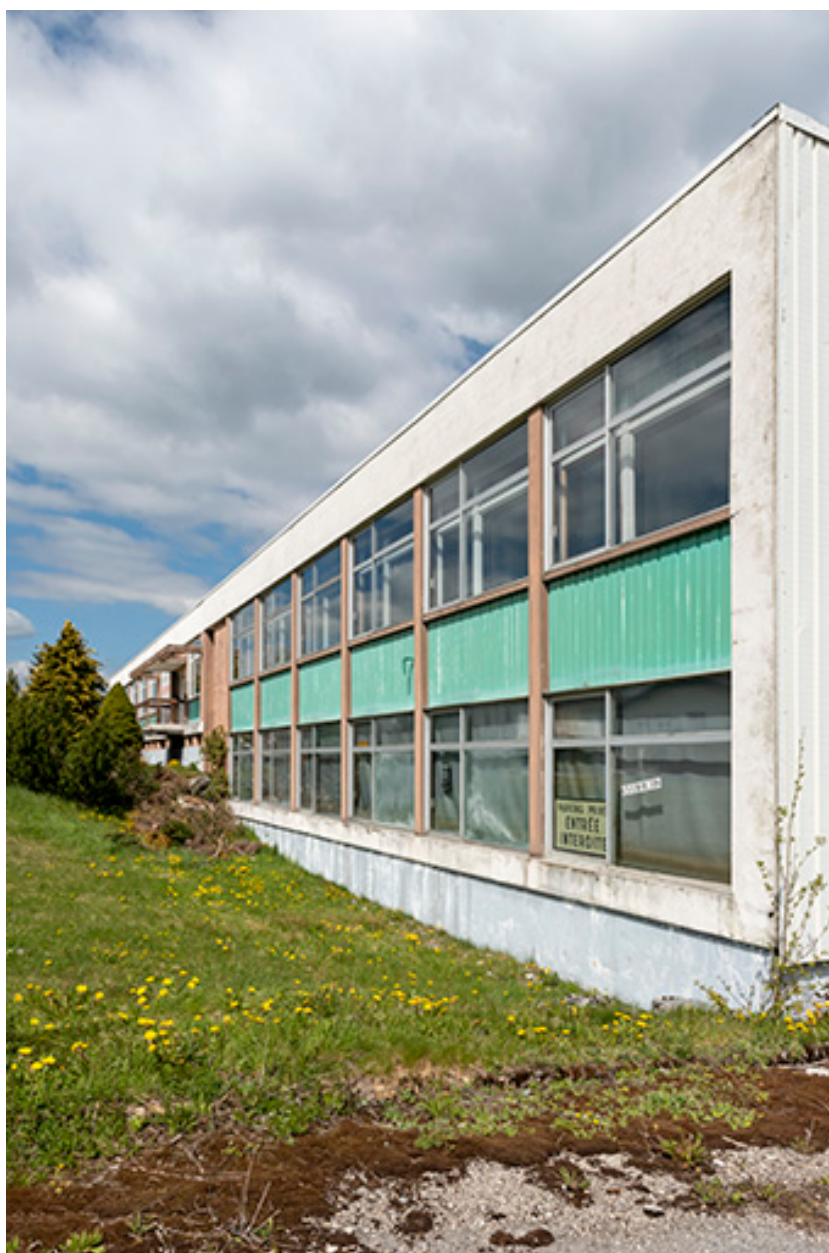
Façade antérieure, vue en enfilade.
