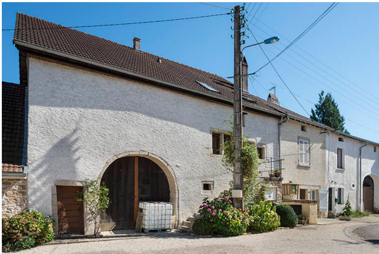
La porte charretière, façade antérieure.
