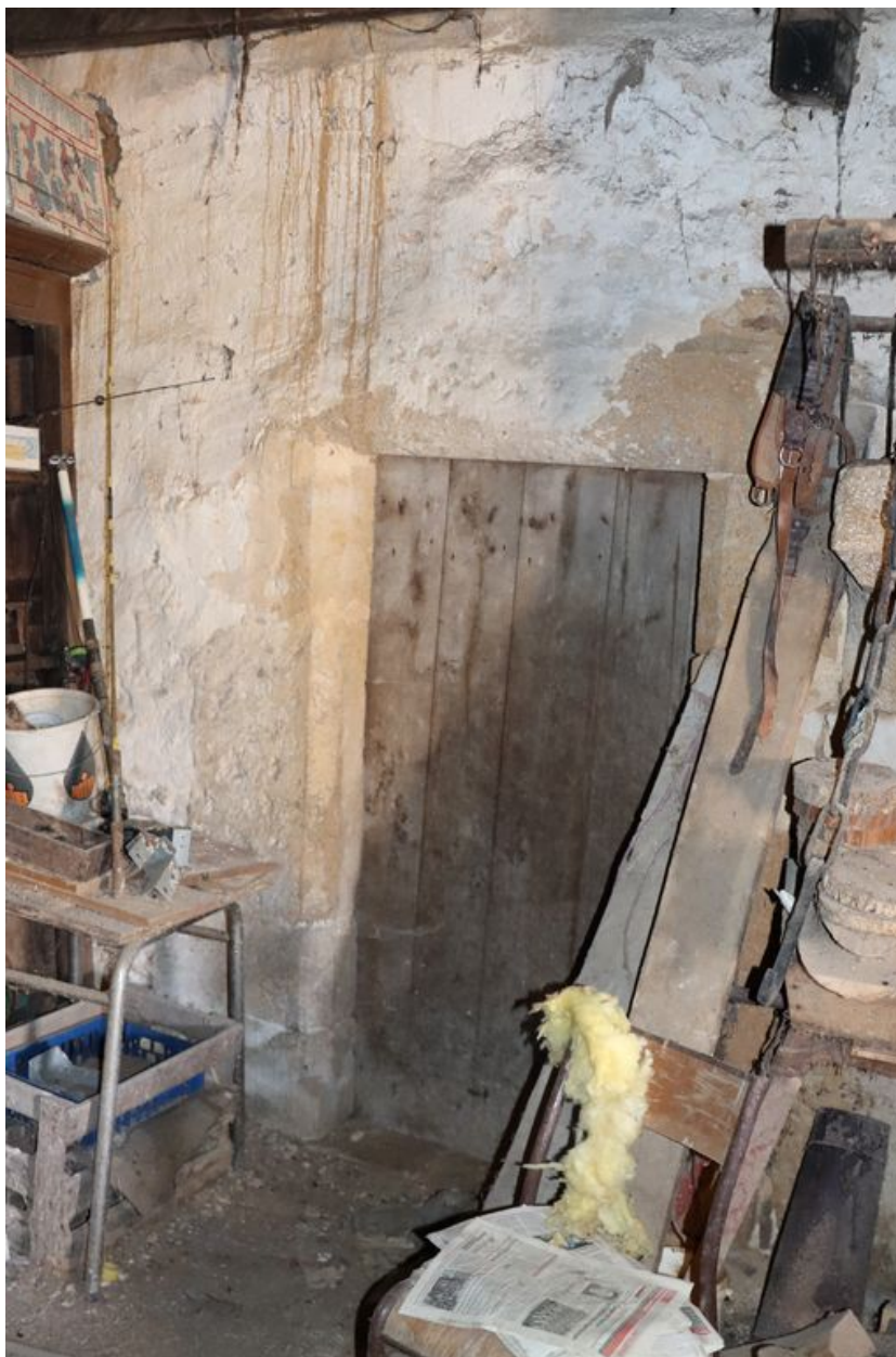
Détail de la porte ouvrant vers l'extension adossée contre le mur pignon sud de la maison.
