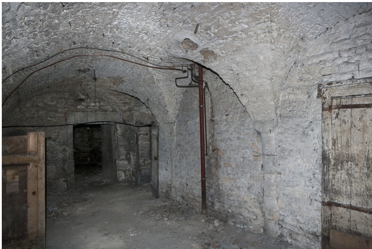
Logis principal, sous-sol : cave C.
