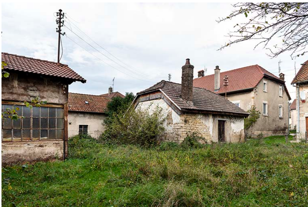
Forge : façades postérieure et latérale gauche.
