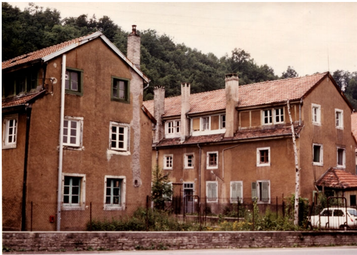
Pignons des ateliers d'origine. Photogr., s.n., s.d. [avant 1980]
