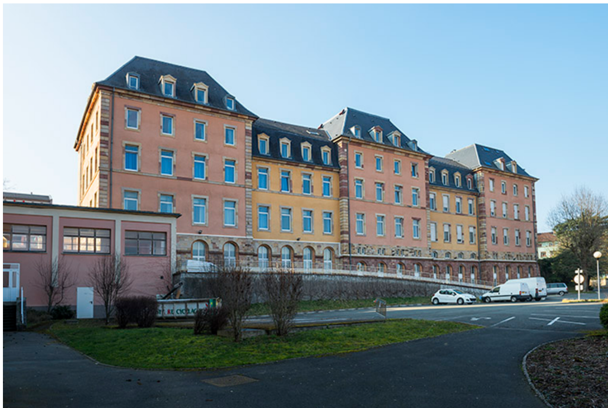
Lycée Condorcet : aile est du grand lycée.
