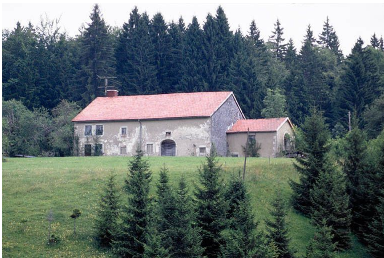
Vue éloignée de la façade postérieure.
