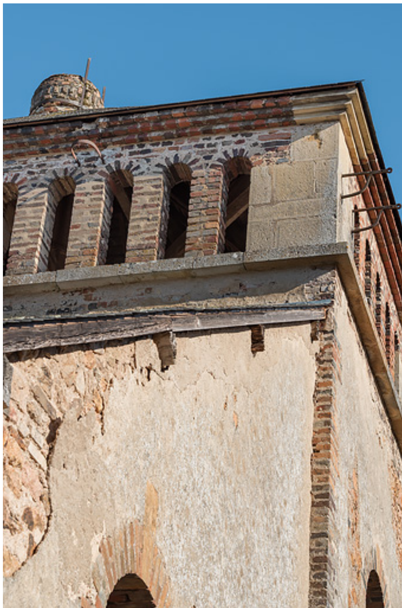
Claire-voie du quatrième niveau.
