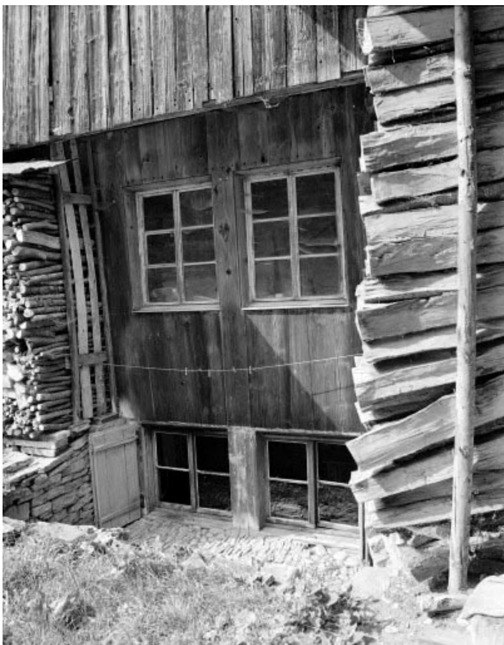
Façade postérieure : fenêtre de la cuisine.
