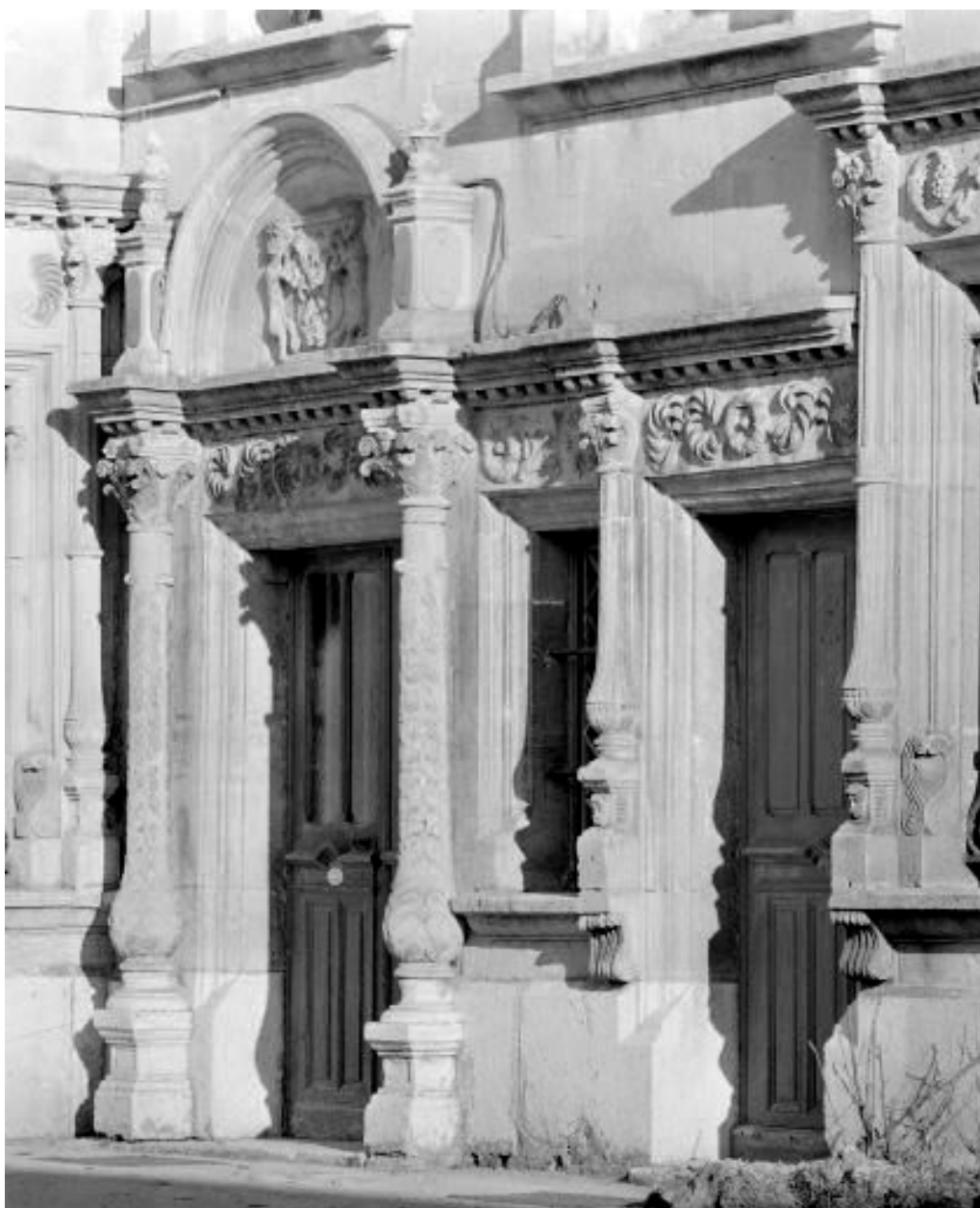
Détail de la porte d'entrée.
