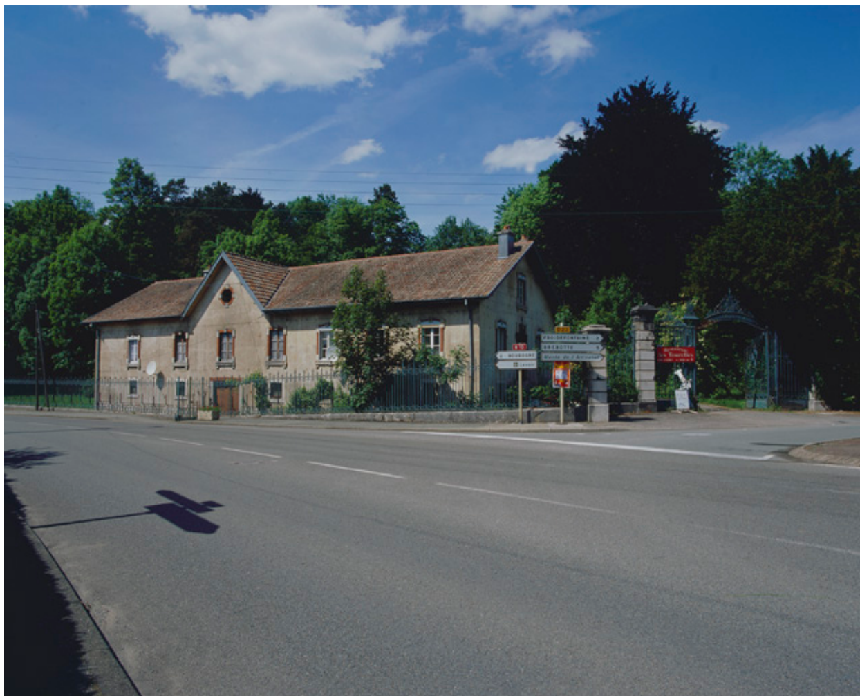
La conciergerie et l'entrée du parc.
