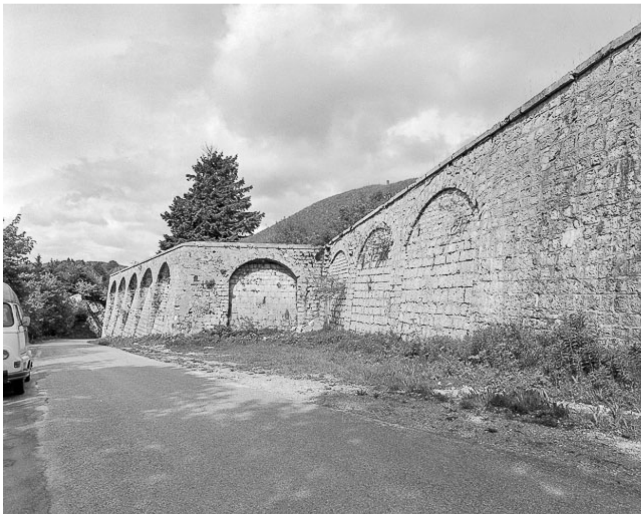
Crénels de pied défendant l'enceinte : vue éloignée.
