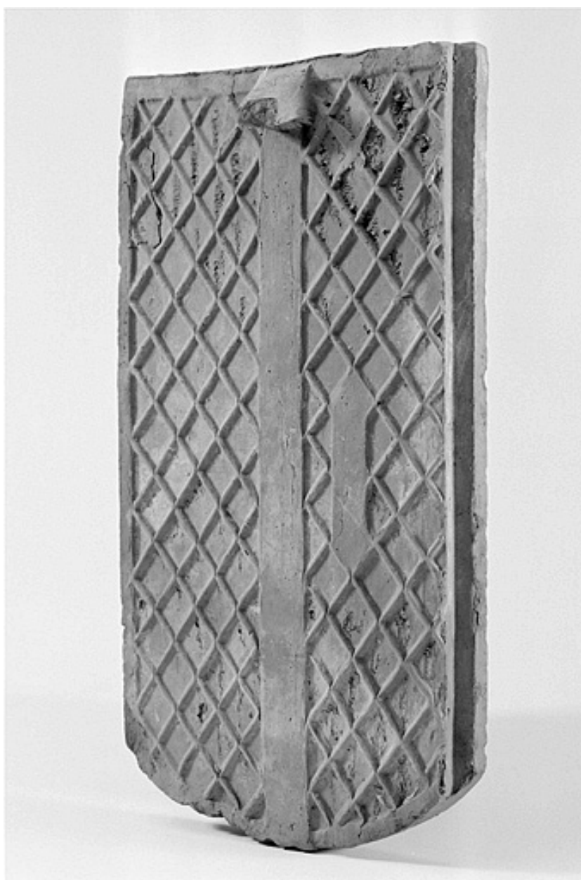
Face intérieure et feuillure d'une tuile-écaille.
