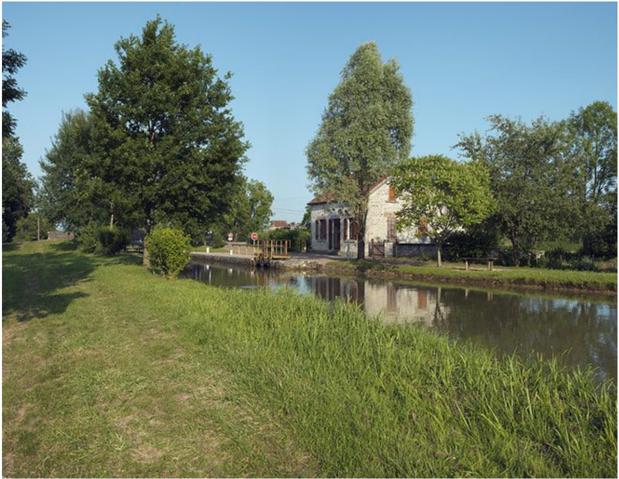
Le site d'écluse, d'amont.
