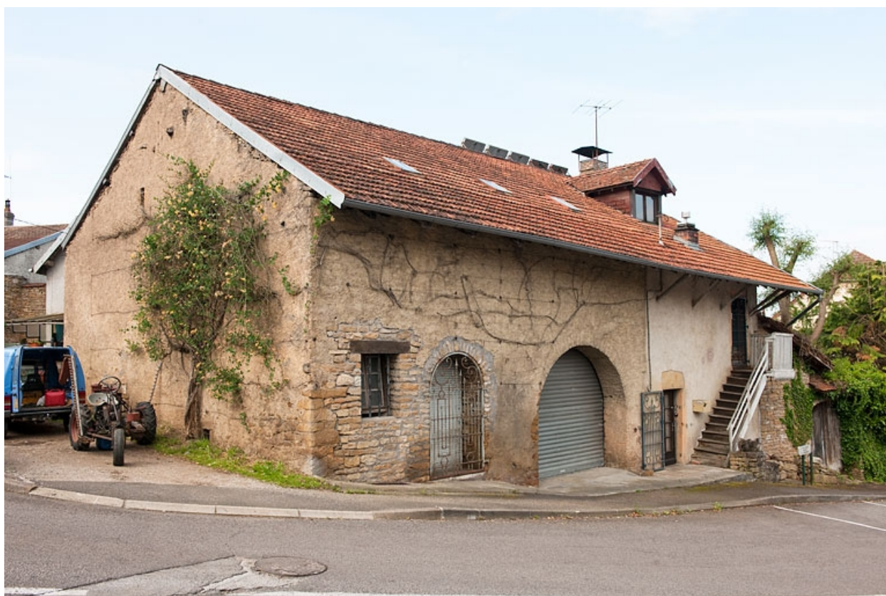
Ferme au 2 rue Maurice Demeusy (2010 AL 416).
