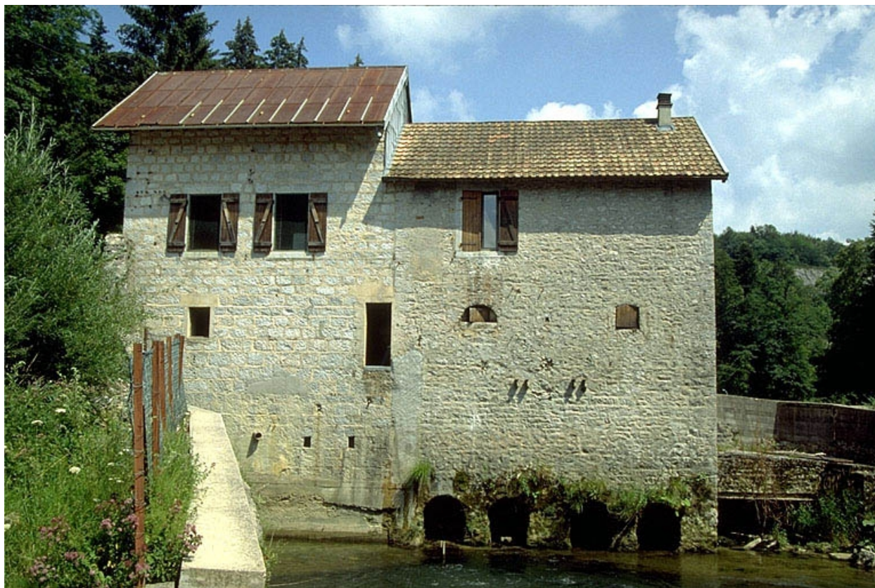
Façade latérale droite.
