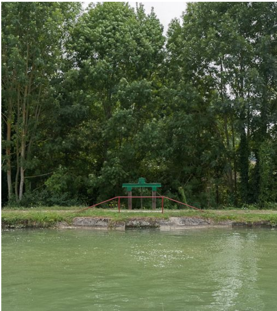
Vanne et déversoir vus du canal.
