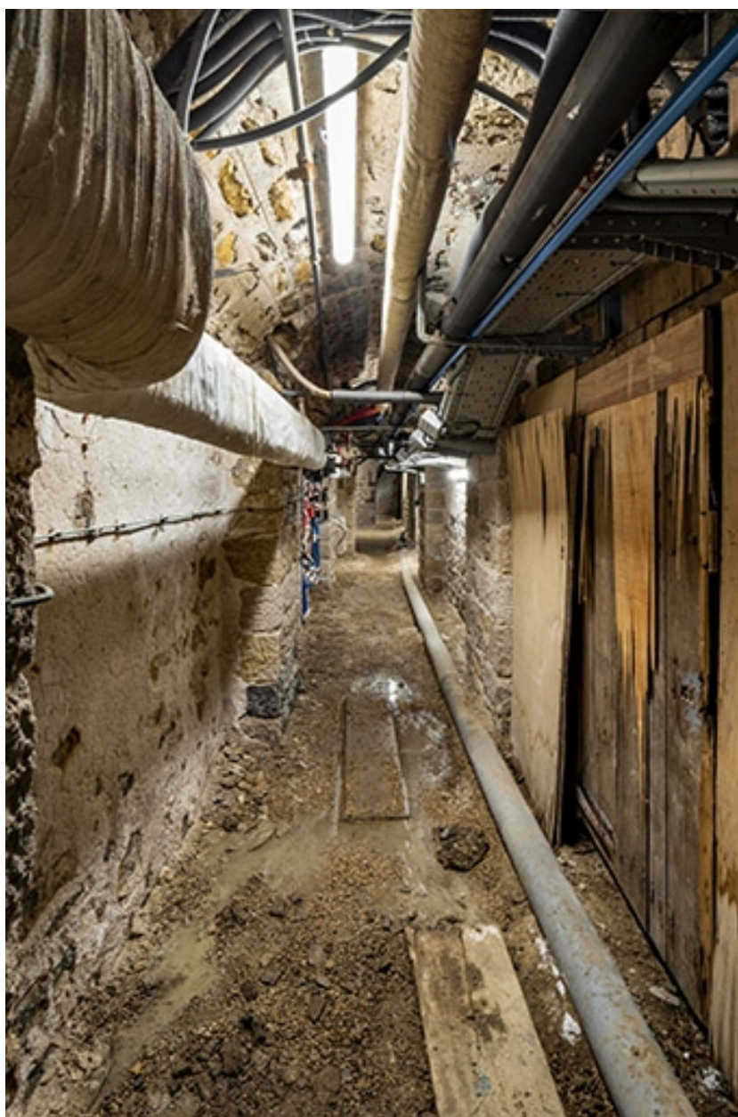
Galerie nord du sous-sol, sous le vestibule.
