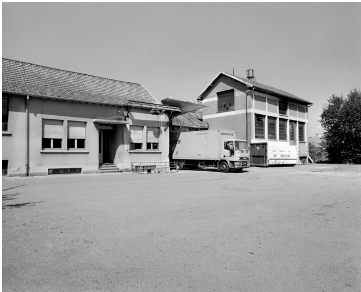
Façade sud et chaufferie.
