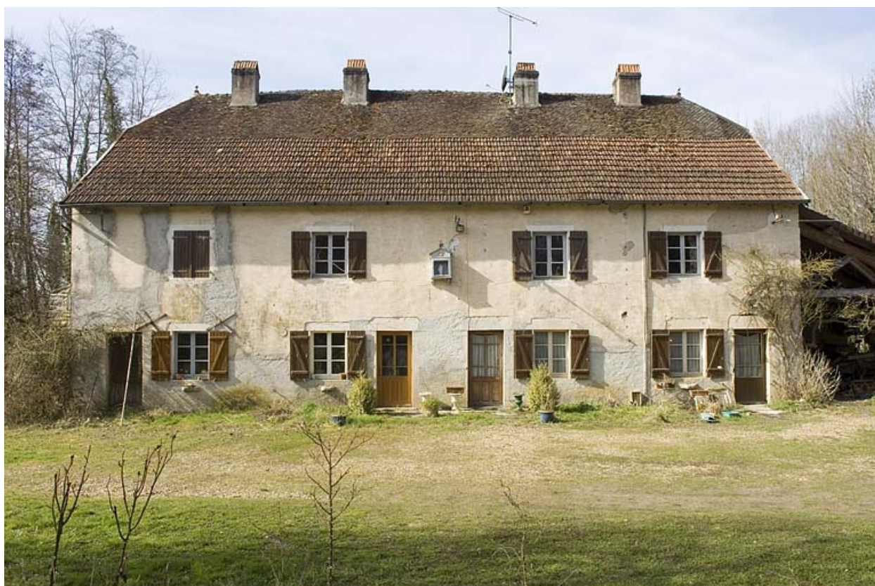
Logement d'ouvriers. Façade antérieure.
